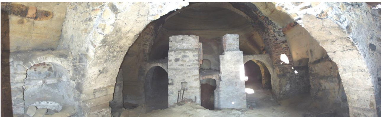
La fornace d'Alessandro. Veduta dell'interno. E' ricavata nella roccia arenaria ed è un esempio di "vita" dei "mastri" ceramisti arianesi. L'interno è formato da un primo ambiente di forma rettangolare dove, è visibile, al centro la fornace di tipo verticale a pianta rettangolare. Si nota l'alta camera di combustione, parzialmente incassata nel terreno, sormontata dalla camera di cottura coperta, in origine, da una voltina costituita da tubuli fittili. subito a sinistra vi è la cisterna con annessa la vasca di decantazione per l'argilla. Sempre sulla sinistra, lungo uno stretto corridoio, si
